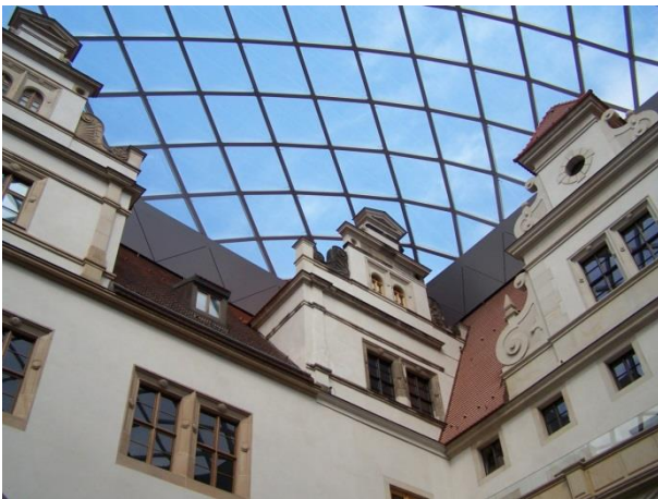
Abbildung 1: Überdachung eines Innenhofs des Residenzschlosses Dresden (links) mit einer transparenten Folie und Dachkonstruktion des Dresdner Hauptbahnhofs (rechts) mit einer transluzenten Membran.
