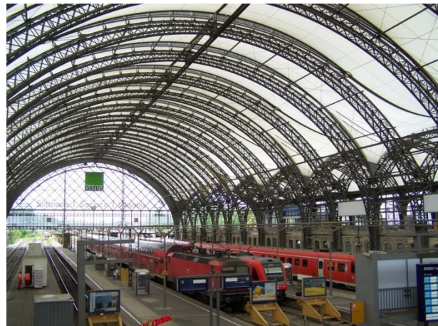
Abbildung 1: Überdachung eines Innenhofs des Residenzschlosses Dresden (links) mit einer transparenten Folie und Dachkonstruktion des Dresdner Hauptbahnhofs (rechts) mit einer transluzenten Membran.
